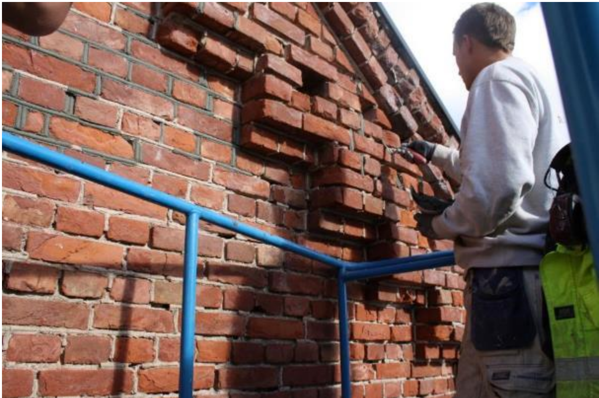
Fra istandsetting av murverk øverst i østgavlen til Kokeriet i 2012. Foto: Anno Museum.
