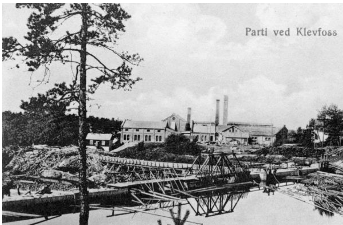
Fig. 21. Anlegget slik det sto fra 1911. Tømmerrenne (vedrenne) fra dammen mot fabrikken. Foto: Normann/Anno museum
