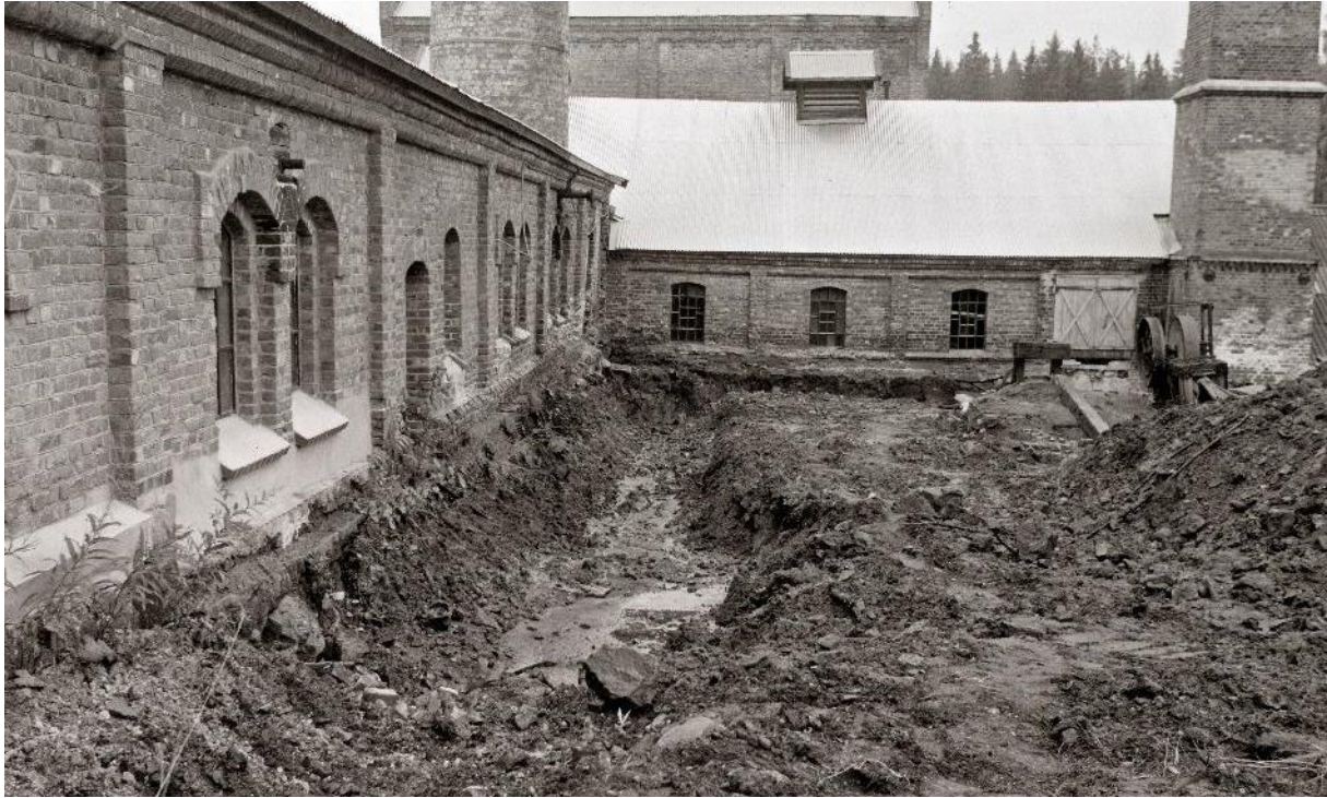
Drensgrøft langs nordsiden av Luthuset og vestsiden av Sodahuset. Foto: RAs arkiv, 1984.
