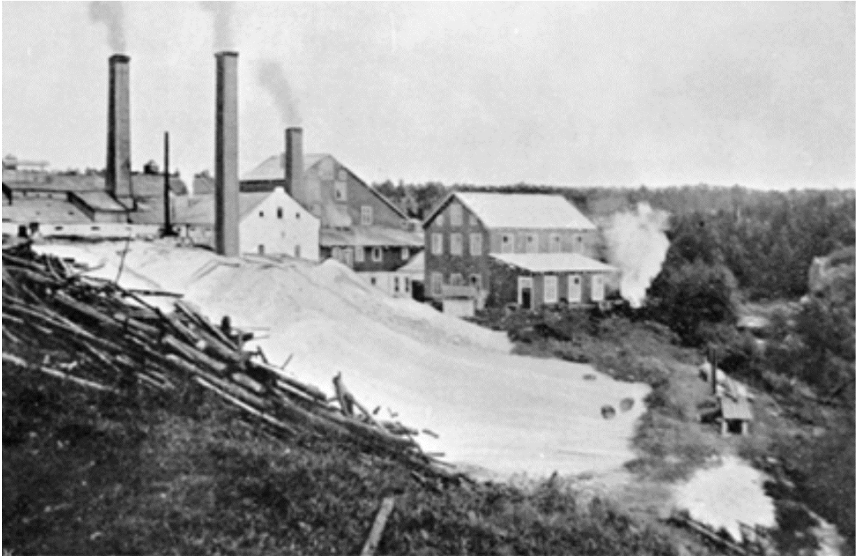
Fig. 14. Anlegget i perioden 1905-1909. Fyrhuspipa er reist, men røyken er trolig fra retusjeringen siden selve Fyrhuset ikke var bygget ennå. Foto: Anno museum
