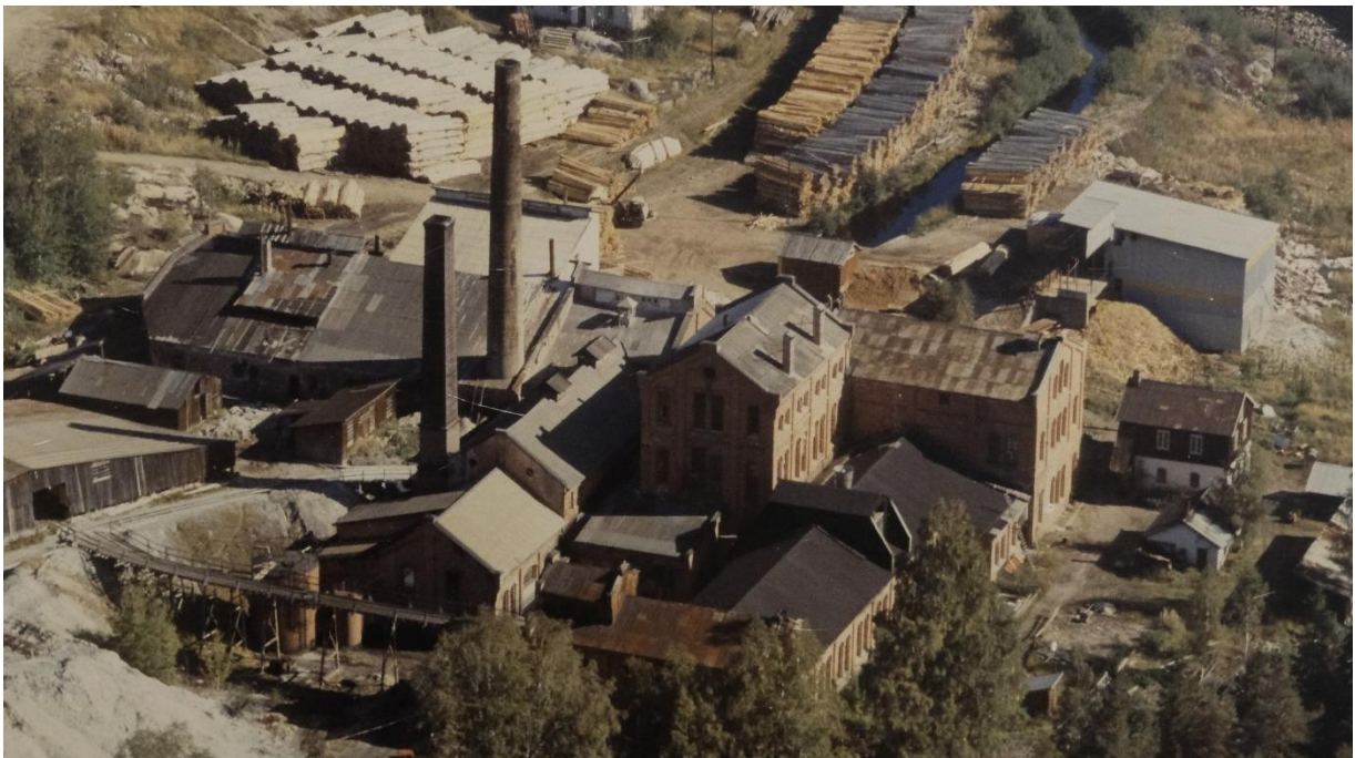
Fig. 30B. Anlegget på 1970-tallet. Dette er et av få fotografier vi har av det nye hoggeriet. Flyfoto som henger på Skjærdal. Foto: Anno museum
