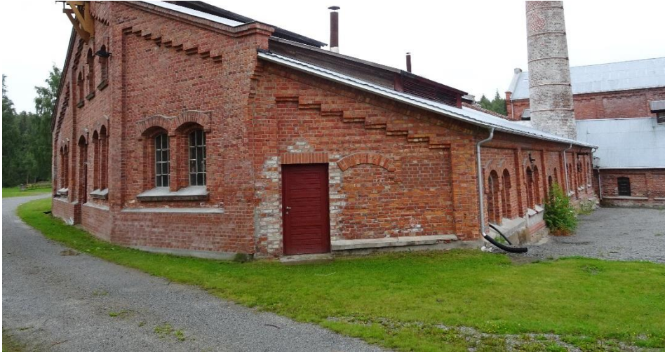
Fra nordsiden av Sodahuset der det vurderes å grave/sprengre for å få ei grøft som avskjærer vann i grunnen.
