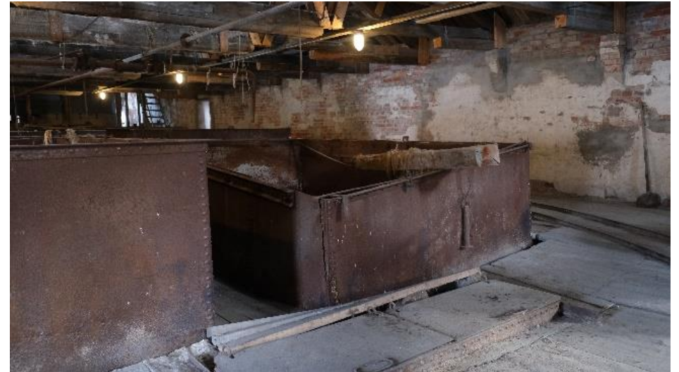
Til høyre det ene silkaret i vest som er nær ved å rase ned i kjelleren (sikret høsten 2021).
