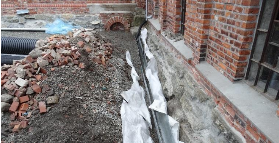
Tiltak for å lede bort overflatevann og takvann ved nordvegg til Luthuset i september 2020.
