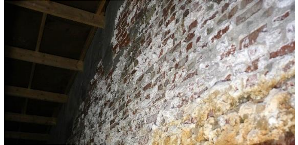
Fra øvre del av sørvegg sett fra Remkanalen.
