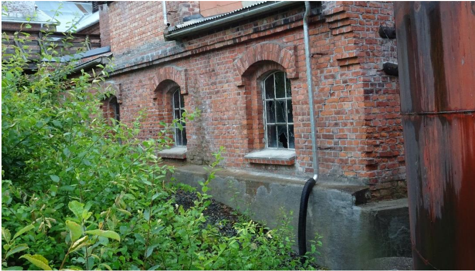
Nordsiden av Fyrhuset sett mot sørøst, nordvegg og vestvegg er sikret med kraftige påstøp (utført i 1995).
