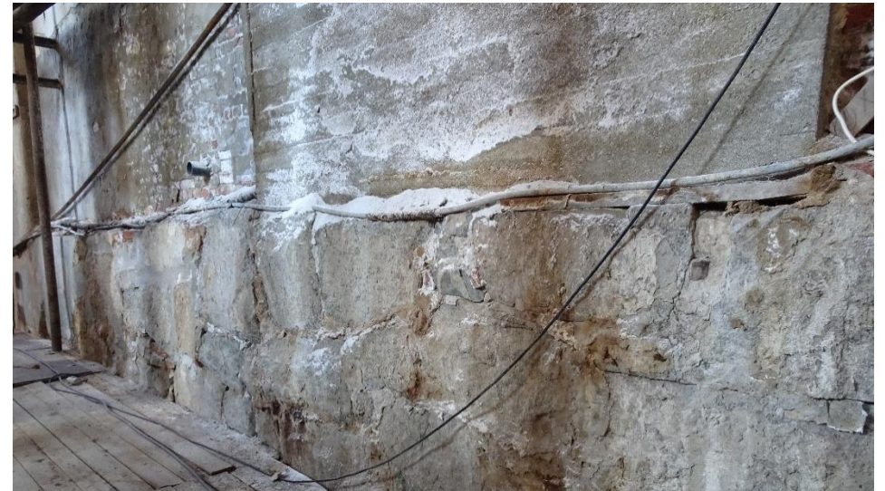
Deler av vegg mot Remkanalen med grunnmur i naturtein og teglvegg stivet av med påstøp i betong.
