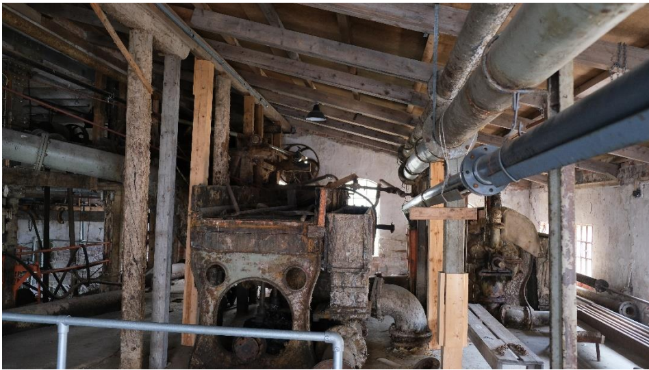
Oversikt innvendig sett fra søndre ende mot nord.
